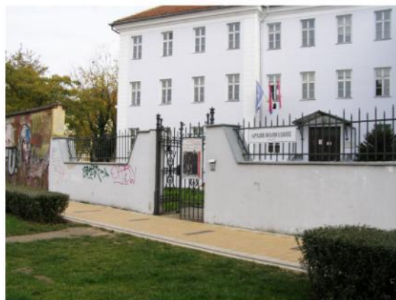
Ulazna kapija i bočni segmenti (u nastavku, levo, postojeći deo koji se rekonstruiše)
