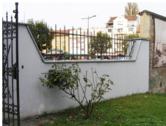
Pogled na planirani i postojeći segment ograde sa unutrašnje strane
