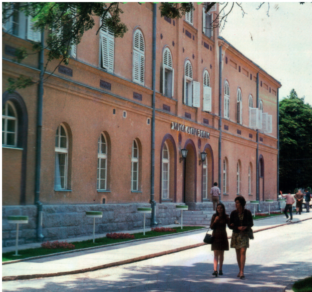
*фотографија 16 - Изілед новодоірађеної дела Сшарој здања іосле адајшацје 1972. іодине
