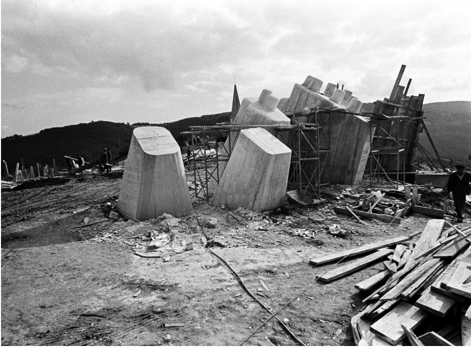
Слика 3: Комплекс током изградње (Фототека НМУ)
