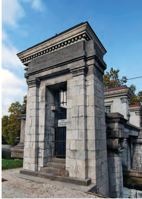
Figure 17. Ljubljana Sluice Gate, Photo by Petr Šmídek, 2008 ( https://www.archiweb.cz/en/b/zdymadlo-na-rece-lublanica-zapornica-na-ljublanici )
