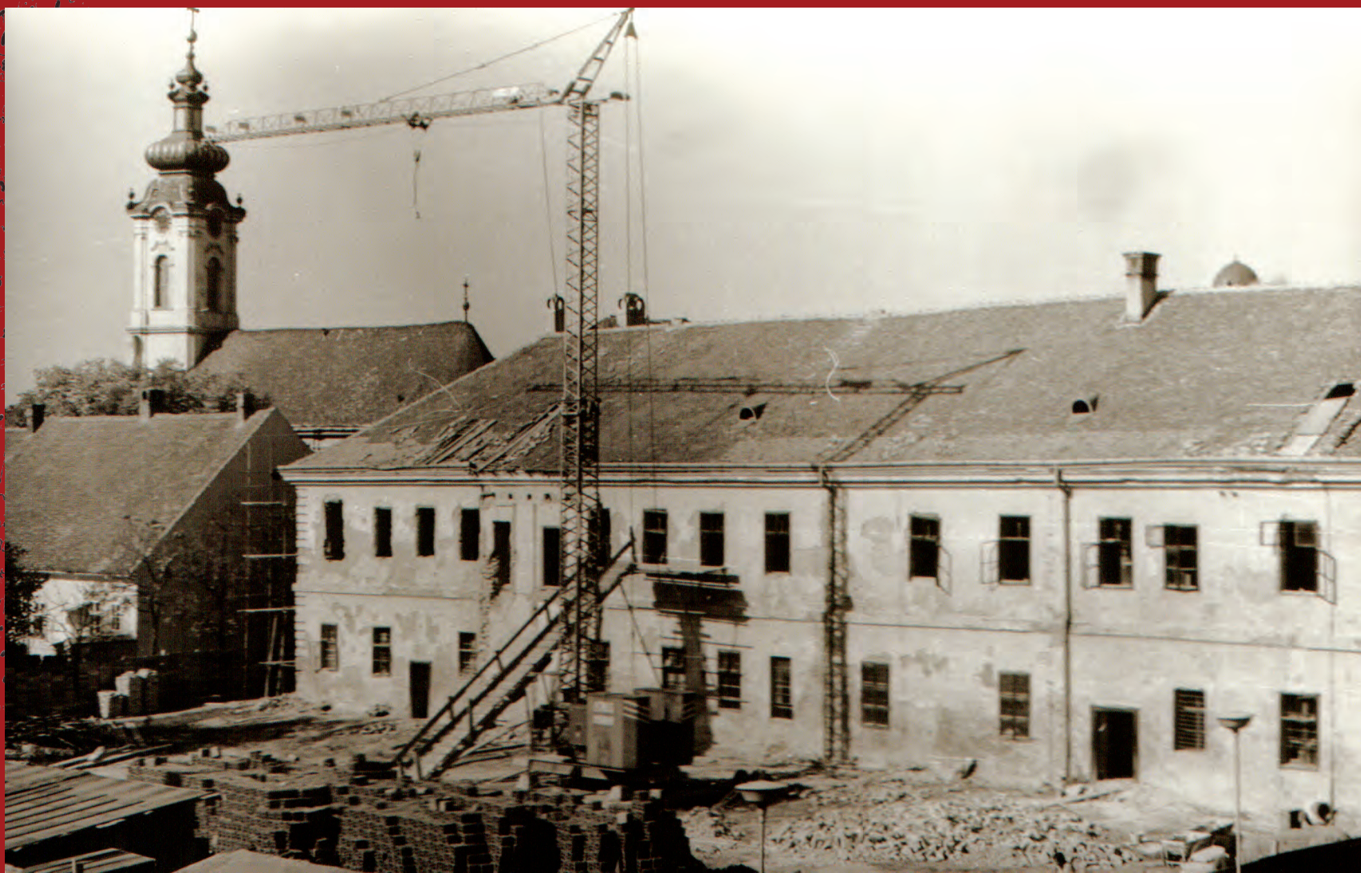
Фотографија зграде Историјског архива „Срем” за време реконструкције 1979. године.
