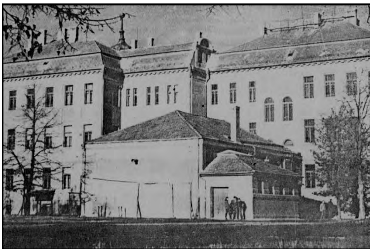
Telocvičňa – konečné indoor riešenie aj pre sokolov
