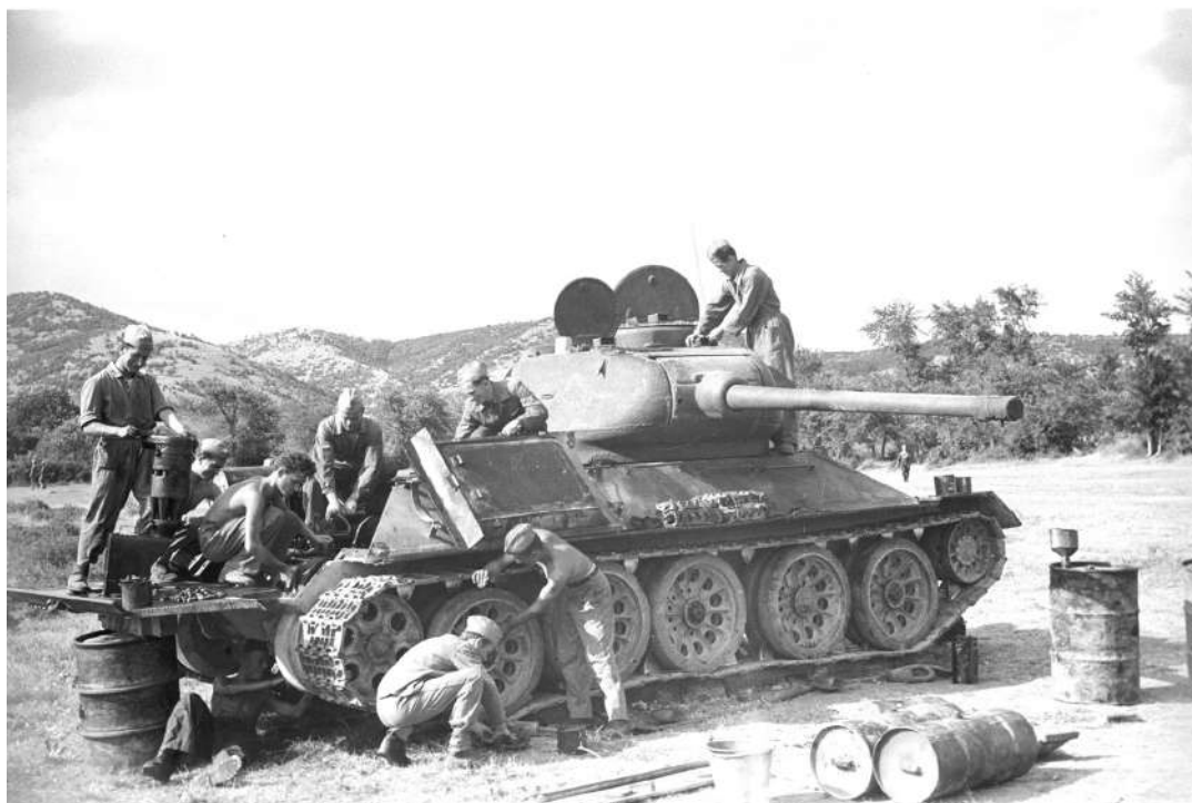
Тенковска бригада на терену 1951. године: рад на моторском и ходном делу једног од тенкова Т-34 (МЦО)
