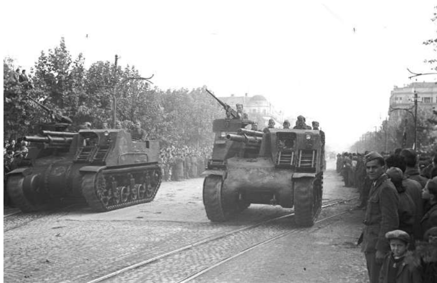
Самоходне хаубице М-7 калибра 105 мм из Тешке артиљеријске бригаде, на паради у Београду 20. октобра 1945. године. Уочавају се разлике у оклопном телу на оба возила (МЦО)
