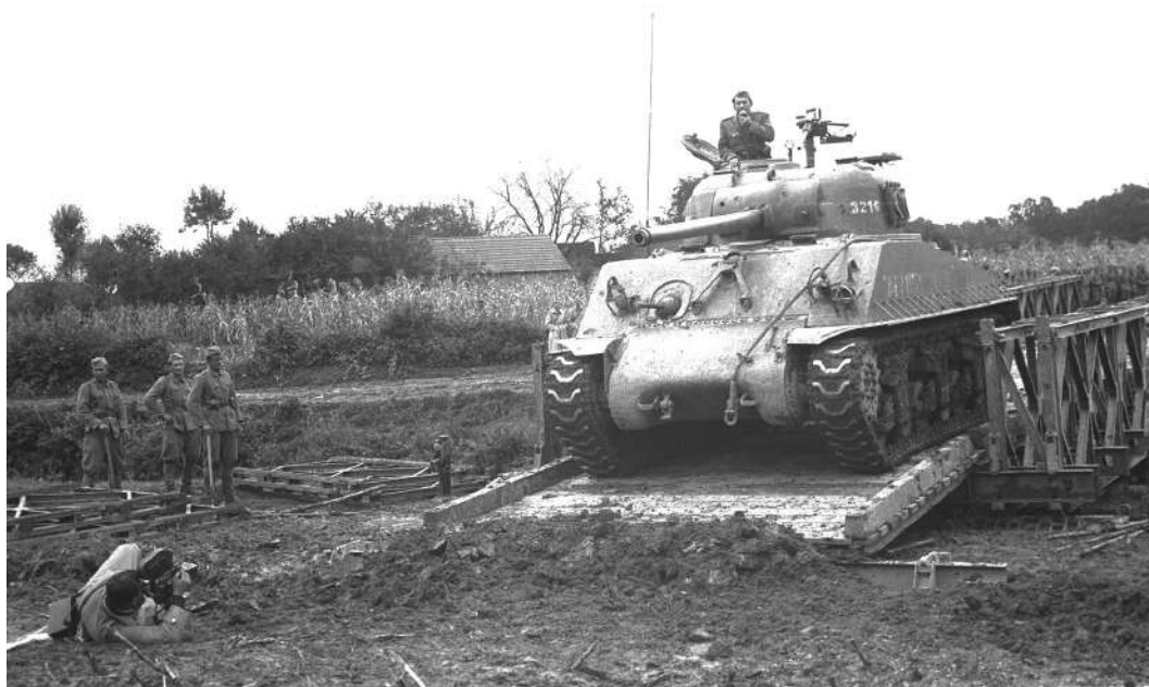
Тенк М4А3 Шерман (3216) прелази понтонски мост америчке производње типа Бејли у току маневра, септембар 1953. године. Камерман војно-филмског предузећа помно прати овај догађај из лежећег става (МЦО)
