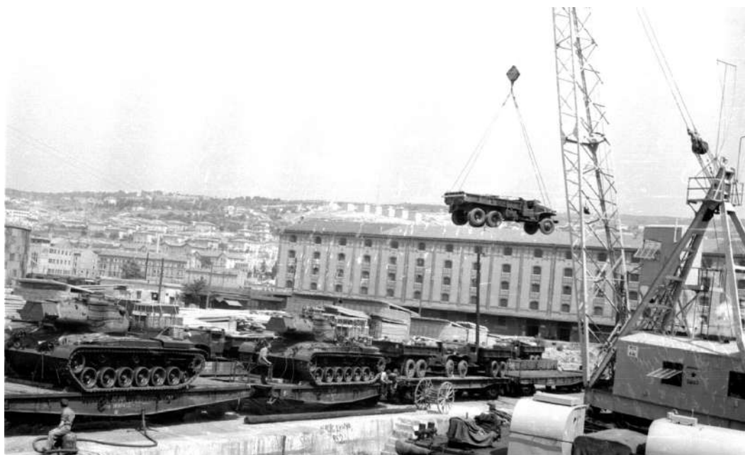
Испорука технике за ЈНА у оквиру система америчке војне помоћи, Ријека 1953. године. На возу већ укрцана количина тенкова М-47 Патон и камиона ГМЦ. Кран управо спушта са брода један од таквих камиона на композицију (МЦО)
