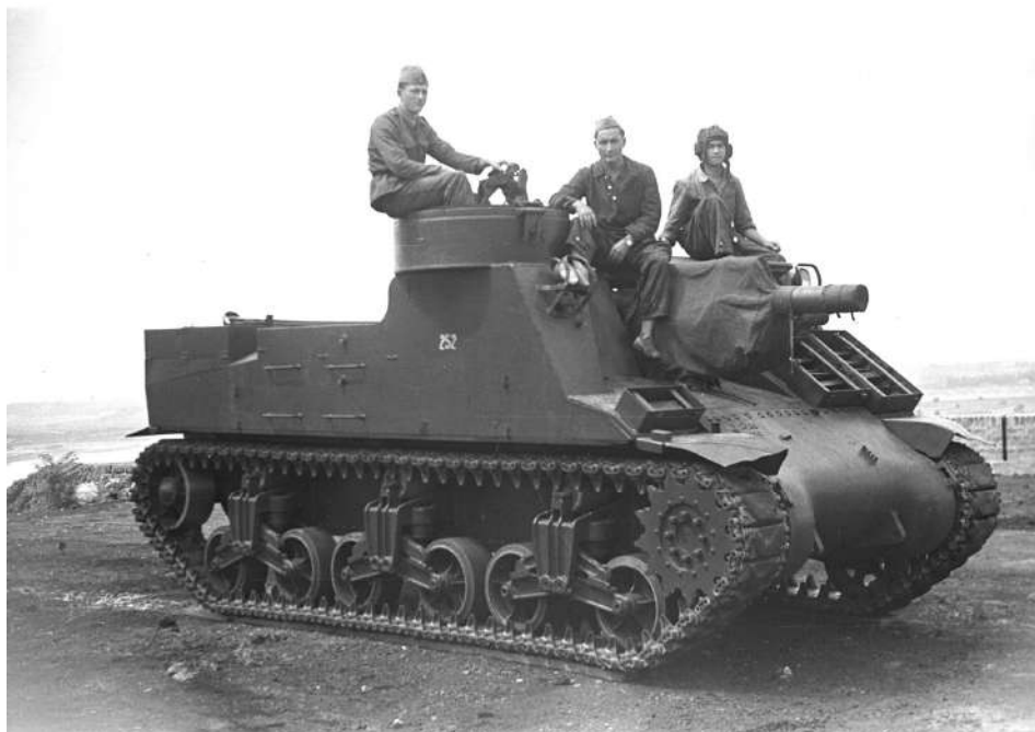
Основно оруђе за подршку у оклопним и механизованим бригадама до почетка 1980-их чиниле су самоходне хаубице М-7 105мм. Овде једна из ратног контингента означена бројем 252 снимљена на Калемегдану 1951. године (Фото-центар)
