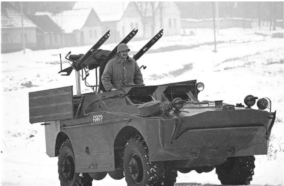
Још једно појачање за противоклопне снаге у оквиру оклопних јединица било је увођење оклопних возила БРДМ-1, верзије 2П27 наоружаних противоклопним ракетама Шмелъ. Овде возило бр. 6862 из јединице у Бачкој Тополи (МЦО)
