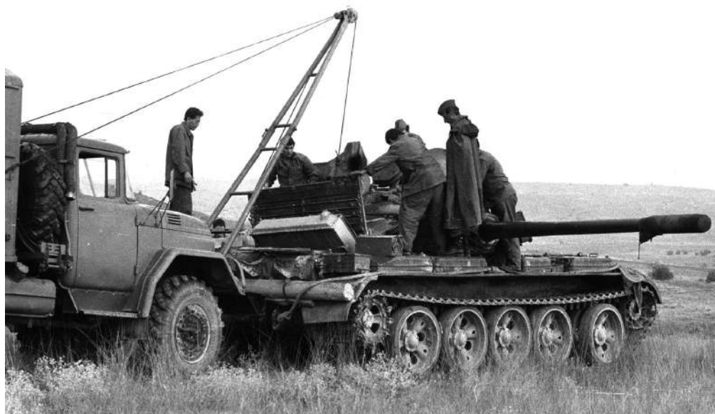
Замена мотора на тенку Т-55 из састава 211. окбр, помоћу крана на камиону-радионици ЗИЛ-131, средином 1980-их година (211. окбр)
